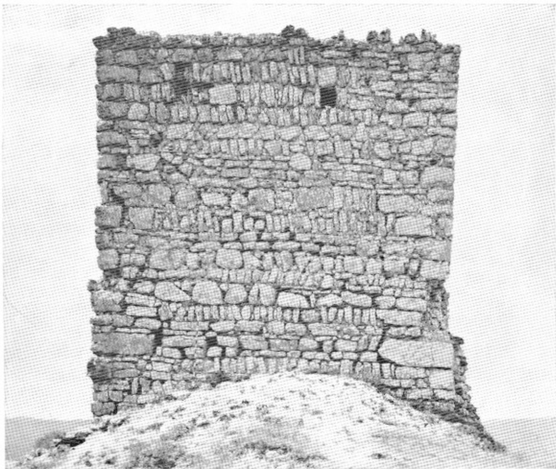
a) Torre del Andador. Fachada Sur. Se aprecia la puerta primitiva tapiada y sin dintel debajo del hueco de la puerta posterior. b) Idem. Fachada Oeste.
