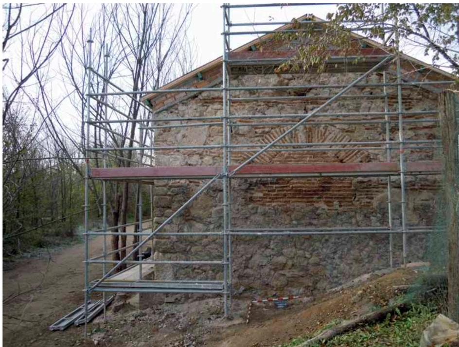
Fig. 2.- Localización del sondeo y vista exterior del muro Este tras la retirada del enlucado de cemento.
