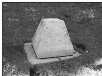
Cuando la galería sufría un fuerte cambio de dirección, se colocaba un arca, llamándose entonces «Cambija»<sup>22</sup>. El motivo de su existencia era el evitar que la acción erosivadora del agua en dichos cambios de dirección socavara el terreno pudiendo producir hundimientos.
