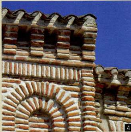
[ ] 1.- CORNISA de Navarredonda (ladrillos cortados en nacela y friso de esquinitas). 2.- CORNISA de Camarma (modillones de ladrillos escalonados). 3.- ALFIZ de Carabanchel (frisos de ladrillos a sardinel y en esquinita). 4.- ARRANQUE de arquería en Prádena (ladrillos cortados en nacela). 5.- CUBIERTA de Cubas (armadura ochavada de par y nudillo, con dobles tirantes y almizate decorado con lazo). 6.- CUBIERTA de Montejo (mismo tipo de armadura, con lacería en madera de roble con mocárabes).
