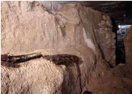
Qanat de la plaza de los Carros, muy deteriorado tras largos años de abandono después de su descubrimiento en los años ochenta. [Luis Olano]
