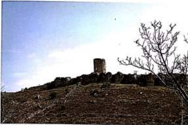
Vistas generales del emplazamiento y del alzado de la Atalaya de El Vellón.
