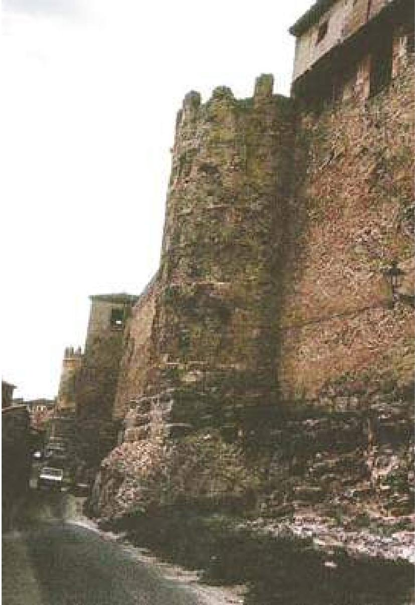
*Fig. 4.- Segovia. Vista de un cubo de la muralla, mostrando las zarpas de tipo emiral de la base*
