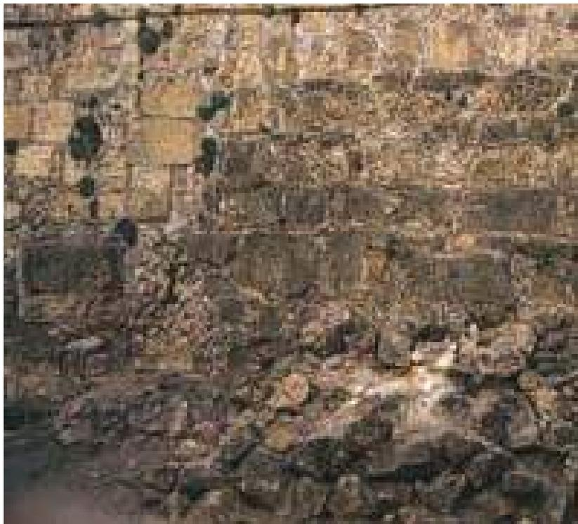
*Fig. 6.- Sepúlveda (Segovia). Vista de cubo islámico, con zarpa, embebido en la muralla posterior.*
