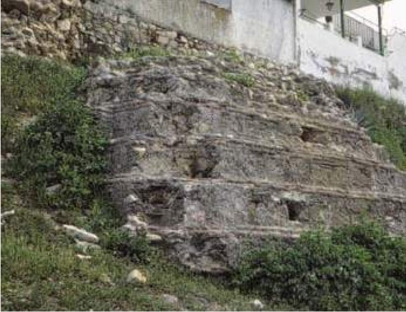
*Fig. 5.- Talamanca del Jarama (Madrid). Base de cubo de la muralla, con encintado de ladrillos.*
