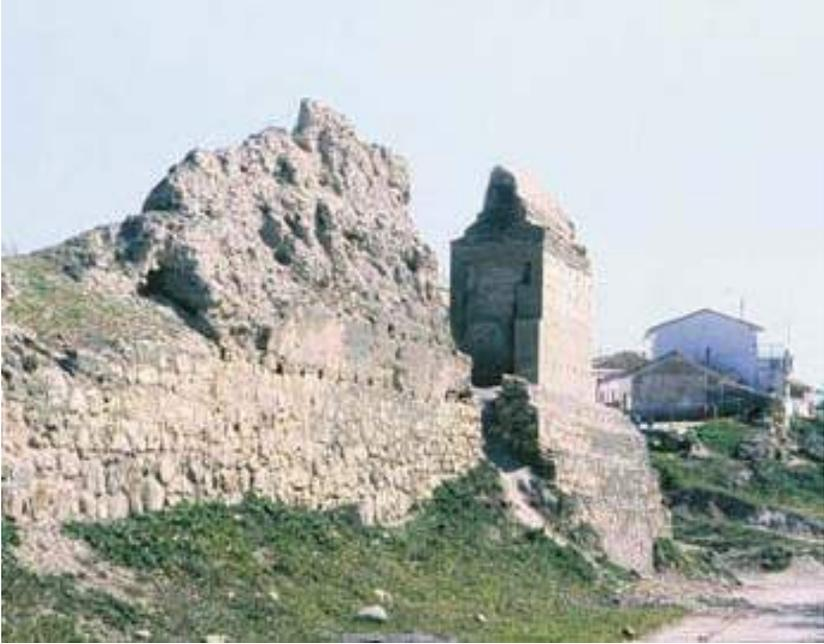
*Fig. 13.-Talamanca (Madrid). Huellas de la fortificación de época de Muhammad I. Se observan restos de un cubo de la muralla, con su zarpa correspondiente, así como el núcleo de tapial entre forros exteriores de sillarejo.*
